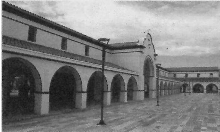
UN HOTEL | EL VIEJO CASCO DEL EX MERCADO DE ABASTO, REMODELADO Y JERARQUIZADO, ES LA BASE DE UN IMPORTANTE HOTEL.
